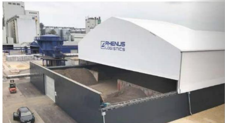
Toiture découvrable en position ouverte.
